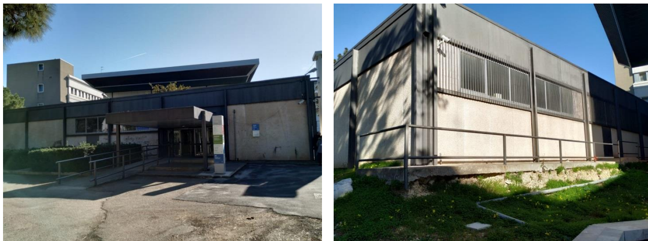
Fig. 2: Stato dei luoghi: Prospetto Nord e Angolo Sud-Ovest
